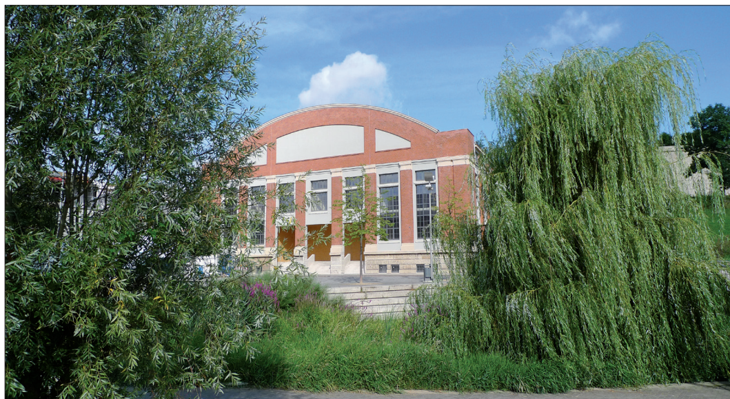
Das Heizwerk ist ein beliebter Ort für kulturelle Veranstaltungen geworden. Foto: LEG Thüringen
