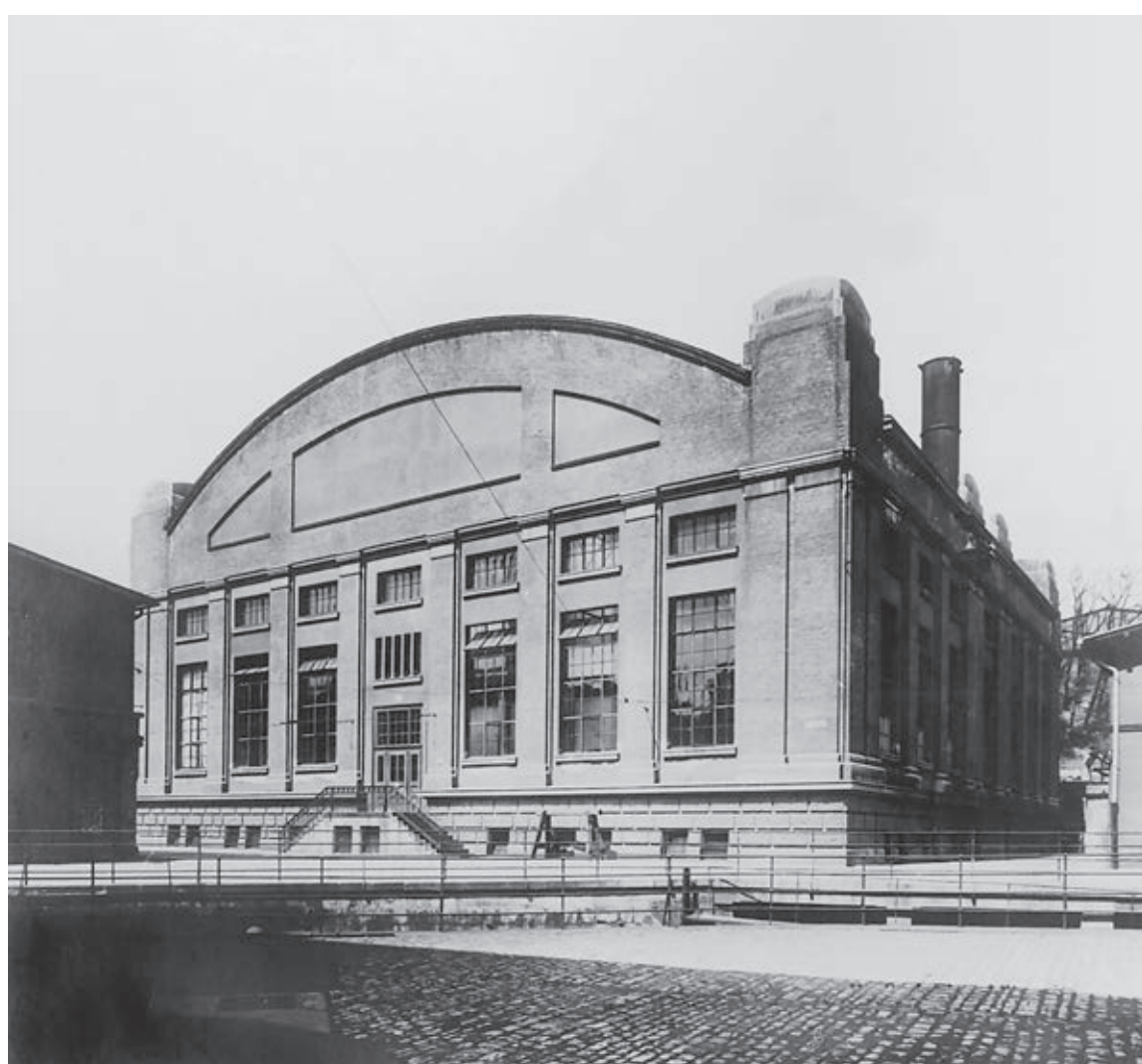
Ansicht vom Heizwerkgebäude (1923) Foto: Stadtarchiv Erfurt
